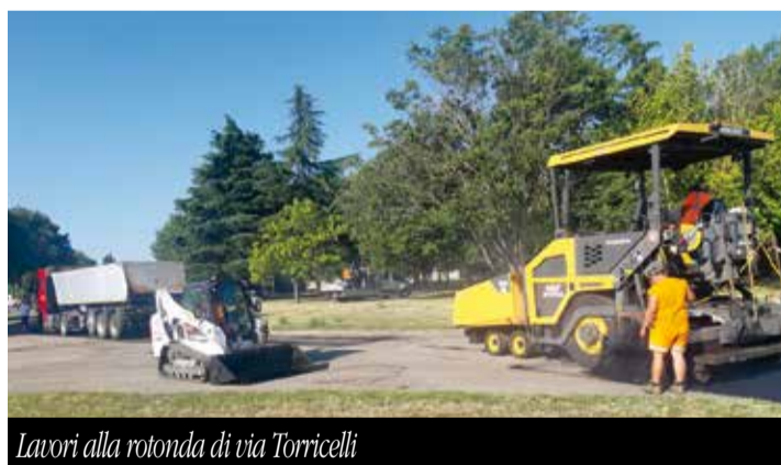
Asfaltatura di via San Giorgio
