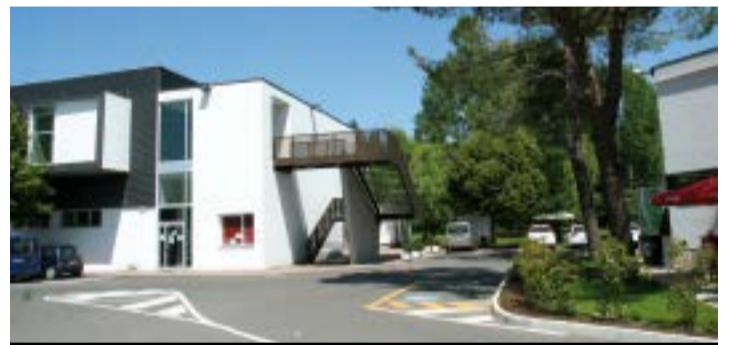
Conclusi i lavori di sistemazione del parcheggio del palasport.
