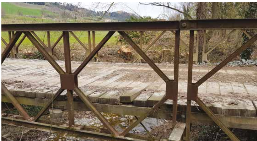
Ponte di Bailey in via Ferraruola a Toscanella di Dozza. (Foto Fabio Avoni)
